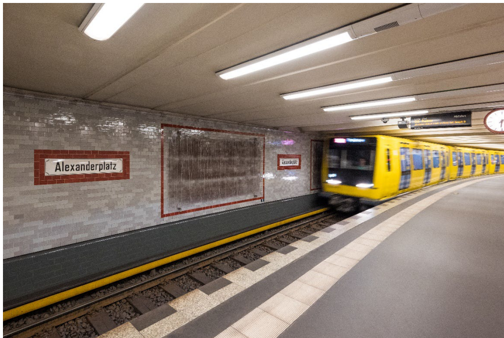
Bald wieder in Betrieb: Gleis Richtung Pankow. Archivbild: BVG, Andreas Süß.
